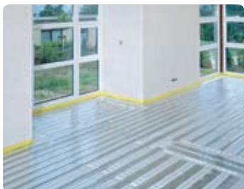
Uponor vieglās konstrukcijas panelis ar siltumu izstarojošām plāksnēm
